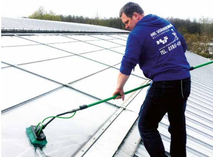
Solarmodule auf dem Dach müssen in regelmäßigen Abständen gereinigt werden. Foto:HDS
