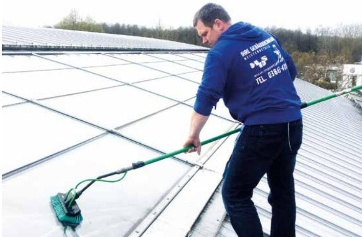
Durch Teleskopstangen wird das Wasser aufs Dach geleitet - so ist auch die Reinigung großer Flächen kein Problem. Foto: HDS
