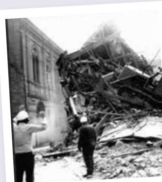
Beim Abriss des Großen Moors 1981 Foto: Stadtarchiv Schwerin /Herbert Wanke
