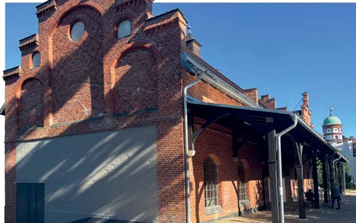
Das Vordach konnte anhand eines historischen Holzmodells denkmalgerecht ergänzt werden. In der Sichtachse ist das Schloss zu sehen.
