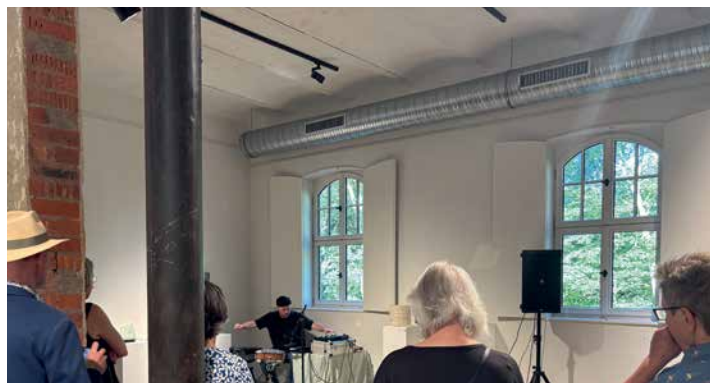
Im Erdgeschoss ist eine so genannte preußische Kappendecke erhalten, die viele Industriegebäude kennzeichnete.
