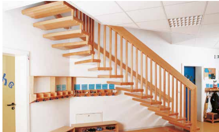
Bei der freitragenden Treppe sind die Stufen nur an einer Seite an der Wand verankert.
