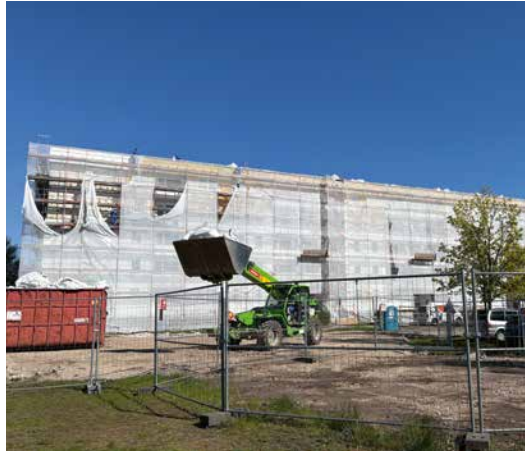
Nach der Entkernung werden die in Systembauweise errichteten Geschosse Platte für Platte abgenommen.
