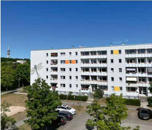
Bild vor dem Umbau: Aus dem Fünfgeschosser wird ein dreistöckiges Wohnhaus.
