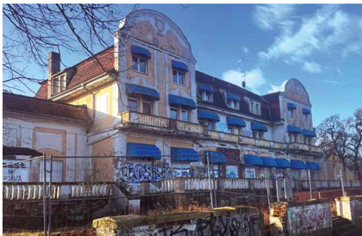
Das Strandhotel heute: Ungenutzt, eingezäunt, verfallen. Ein Gutachten legt jetzt den Abriss nahe.
