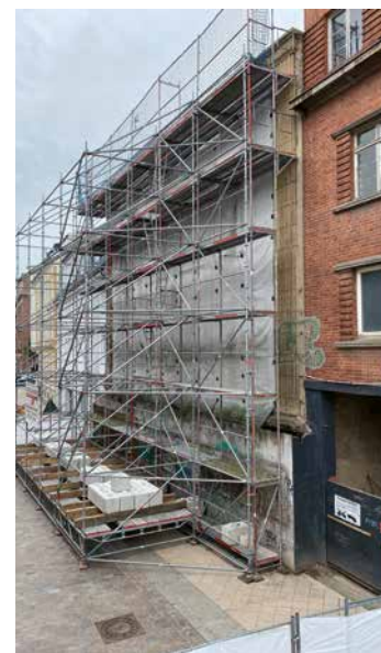
Kurz vor dem Abriss: Im September wurde die Fassade abgebrochen.
