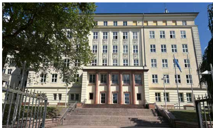
Der zweigeschossige Eingangsbereich vor der breiten Treppe vermittelt einen monumentalen Charakter.
