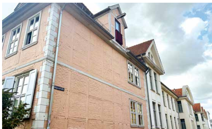
Eine Aufzugsgaube befindet sich auf der Nordseite zur Röntgenstraße, direkt daneben wurde das Krankenhaus errichtet.
