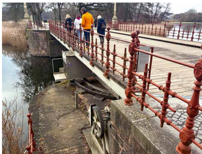
Auf einem zentralen Lager, dem so genannten Königsstuhl, kann die Brücke gedreht werden. Foto: Katja Haescher
