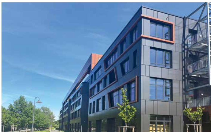
Das neue Haus 7 des TGZ bietet Platz für Büros, Labore und Produktionsstätten.
