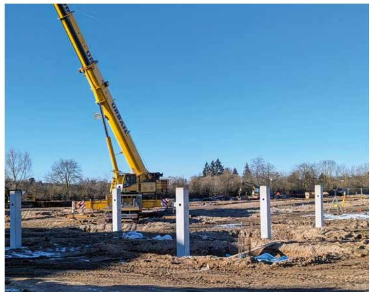
Die Stützen wurden mit Hilfe des Krans in die Erde gesetzt und im Fundament verankert.
