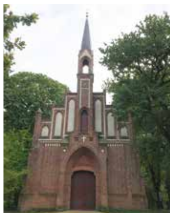
Im viergestaffelten Giebel befindet sich ein leicht vorgezogenes Portal.
