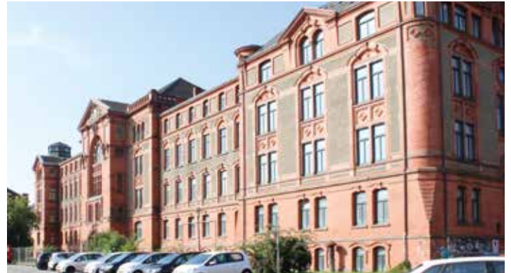
Der größte Teil des Gesamtkomplexes wurde 1898 bezogen. Das kleinere Stück hinten links neben dem Haupteingang entstand 1886. Fotos: Ronja Schlüter
