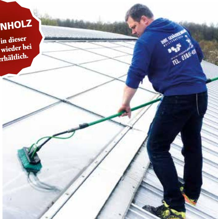
Das Reinstwasser befreit über den Bürstenkopf an einer Wasserrohrstange glatte Oberflächen von Schmutzpartikeln.
