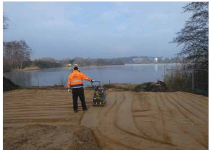
Die Vorbereitungen für den Brückenschlag haben auf der Krösnitz begonnen. Voraussichtlich im September wird die Querung fertig sein.
