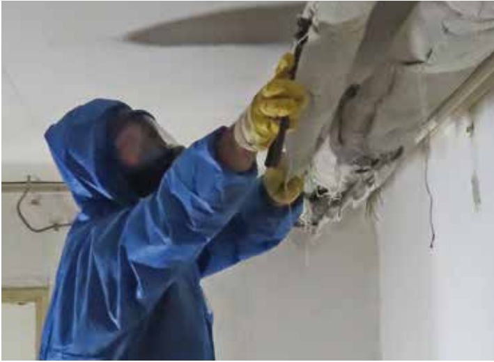
Remo Benthin von der Firma SAR Große bei der Entfernung der Asbest-Isolierung und der Teerpappe. Erst wenn alle Gefahrstoffe entsorgt sind, kann das Gebäude abgerissen werden.
