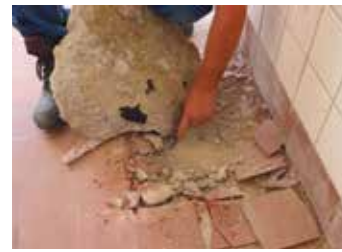
Remo Benthin von der Firma SAR Große bei der Entfernung der Asbest-Isolierung und der Teerpappe. Erst wenn alle Gefahrstoffe entsorgt sind, kann das Gebäude abgerissen werden.
