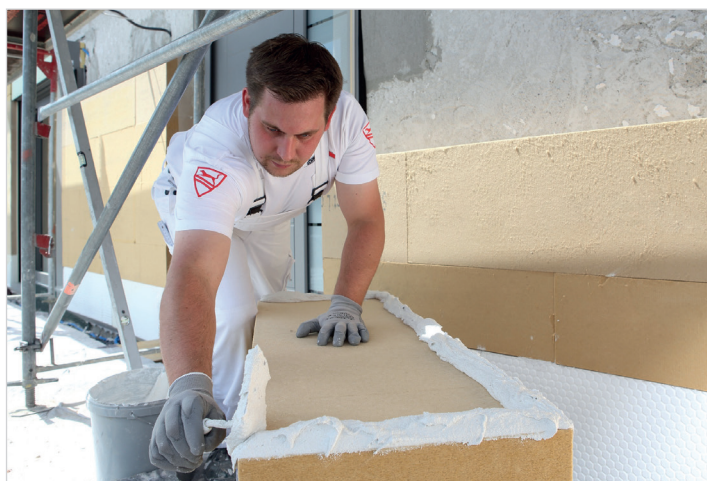
Fachleute verlegen die Holzfasermatten professionell.
