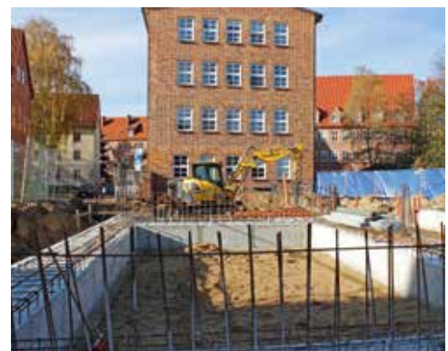
Dank des guten Wetters bis in den November gingen die Arbeiten bereits gut voran. Der Grundstein wurde in ein fast fertiges Fundament gelegt.
