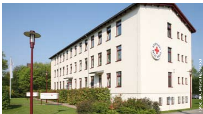
Das Gebäude des DRK Blutspendedienstes in der Wismarschen Straße 298
