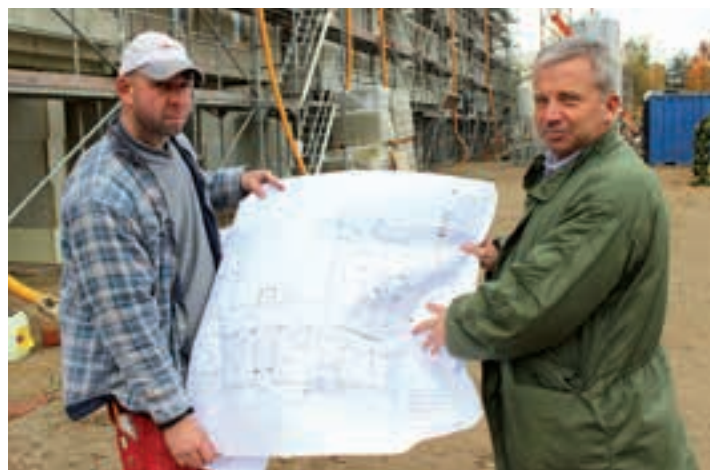
Klaus Haller (re.) und sein bauleitender Monteur Andreas Panzer begutachten vor Ort noch einmal die Pläne für die Baustelle in der Pilaer Straße. Fotos: Hultsch
