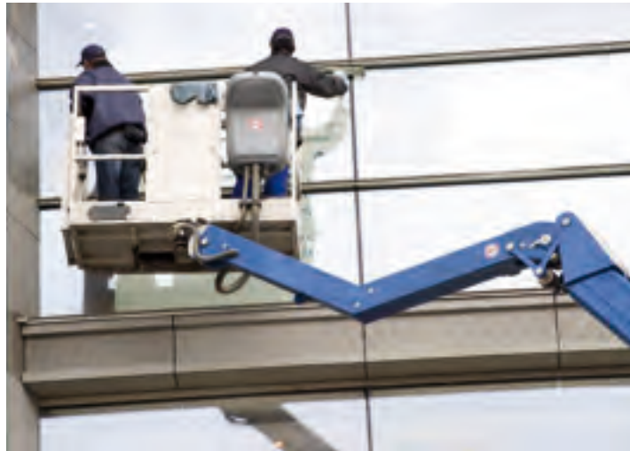
„Wir machen so gut wie alles möglich“. Das Putzen von Fenstern und Glasfassaden gehört zum Portfolio vom HDS Haus- und Dienstleistungsservice.
