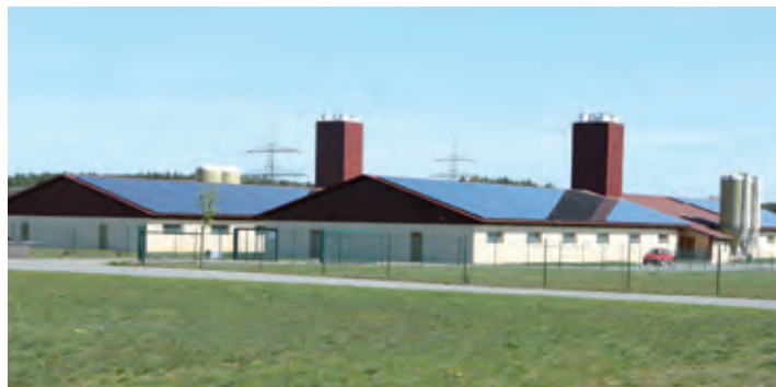
1.753 Solarpaneele auf Satteldächer montiert: Auf 1.262 m 2 wird eine Spitzenleistung von bis zu 136 kWp erzeugt.
