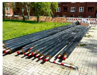
Neue Fernwärmerohre werden am Obotritenring und in der Sibeliusstraße verlegt. Foto: SWG
