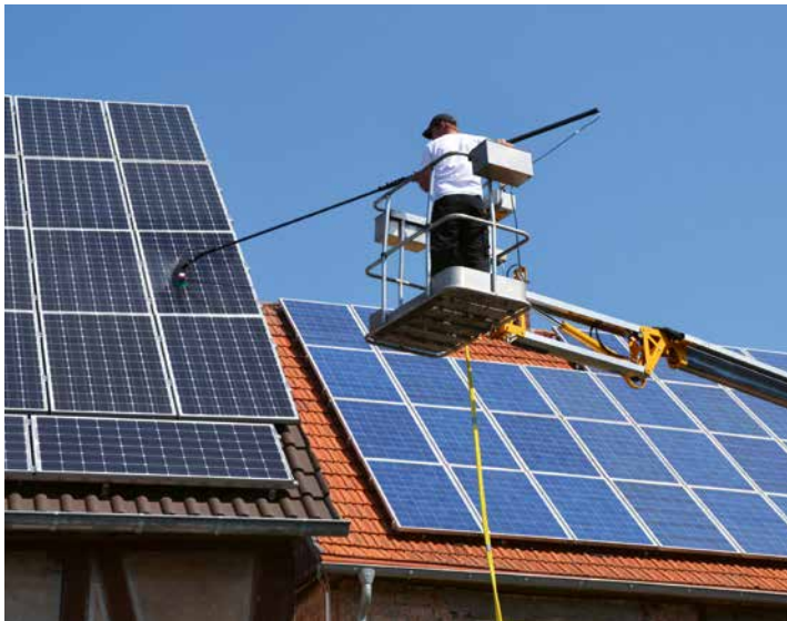
Die Reinigung von Solarmodulen ist wichtig, um einen optimalen Wirkungsgrad der Kollektoren zu erreichen.
