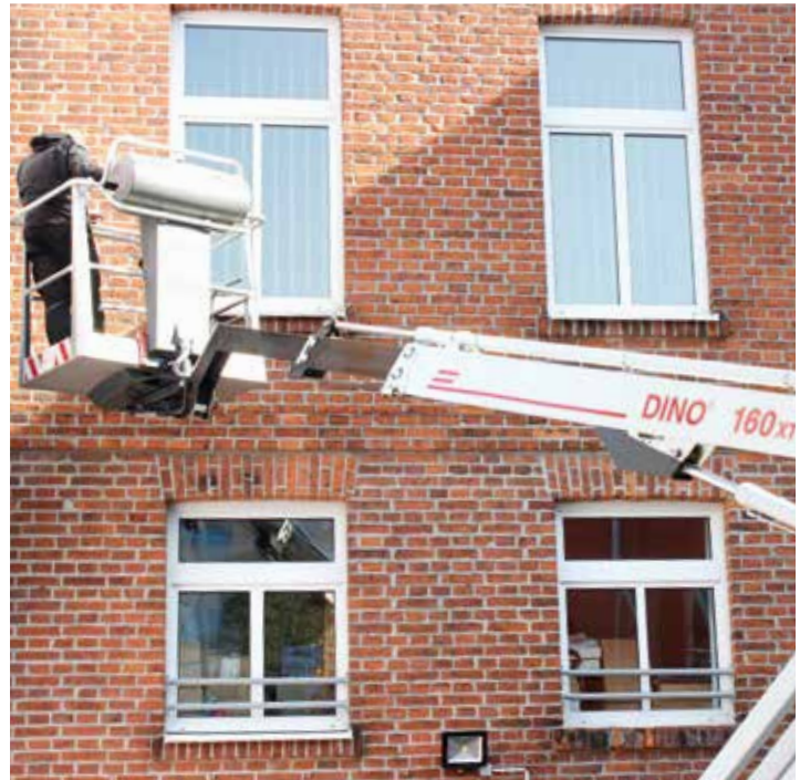
Der „Dino 160“ wird direkt an der Arbeitsstelle mit einem Selbstfahrmotor justiert und kann versetzt in verschiedenen Winkeln arbeiten. Foto: SN live
