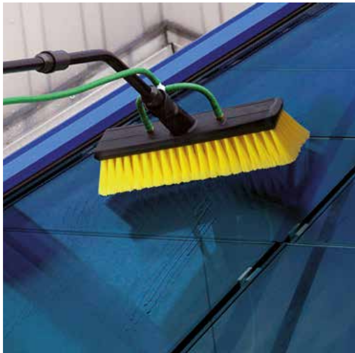
Über einen langen Stab und eine spezielle Bürste wird mit Reinstwasser gearbeitet, das Schmutzpartikel anzieht wie ein Magnet.
